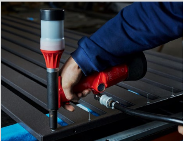
SESTAVOVÁNÍ PLOTOVÉHO POLE VE VERZI MALACHIT. SPOJOVÁNÍ JEDNOTLIVÝCH PRVKŮ POMOCI TRHACÍCH NÝTŮ.
